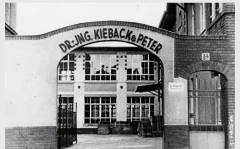
Weitsichtig: Pionierarbeit und intelligente Lösungen für die Automation von Gebäuden haben Produkten von Kieback&Peter internationale Bedeutung eingebracht.
