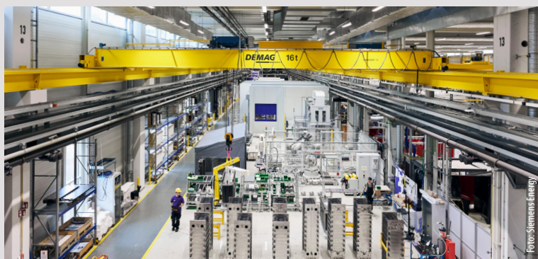
Think big: Die neue Gigawatt-Fabrik von Siemens Energy in Berlin liefert die Stacks für das Wasserstoff-Großprojekt
