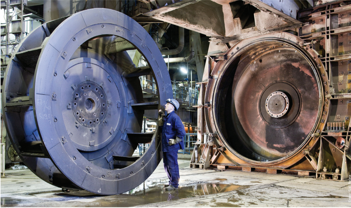
Damit die Energie fließt: Die Schlagräder, die Braunkohle zerkleinern, gehören zu den Herzstücken eines Kraftwerks.
