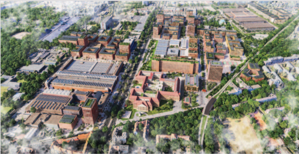
Tief im Westen: Die Siemensstadt gibt es seit 100 Jahren, doch jetzt soll sie der Trendsetter für eine innovative Verbindung von Arbeit und Leben sein.
